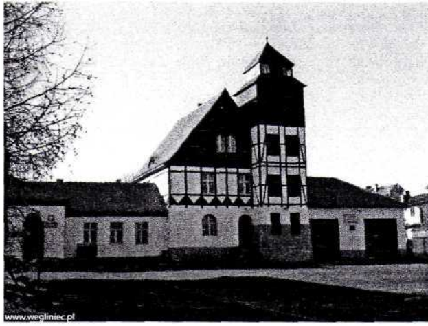
Rys. 4 Budynek po straży pożarnej w Węglińcu
