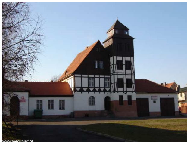
Rys. 4 Budynek po straży pożarnej w Węglińcu
